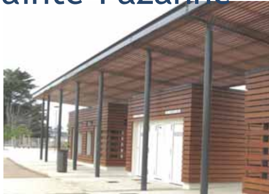
Gare routière de la Baule, M2VT Atelier Sainte-Pazanne, 2010
